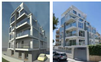
Edificio de apartamentos con sótano. Benalmádena Costa, Málaga (España). MAS arquitectos. Modelado BIM con Revit.
